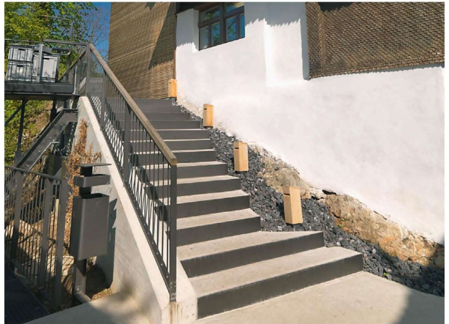
Stahl spielt eine grosse Rolle bei den Ausstattungselementen auf der Insel Schwanau. Selbst die Stirnseiten der Betonstufen sind mit Stahl verkleidet.
