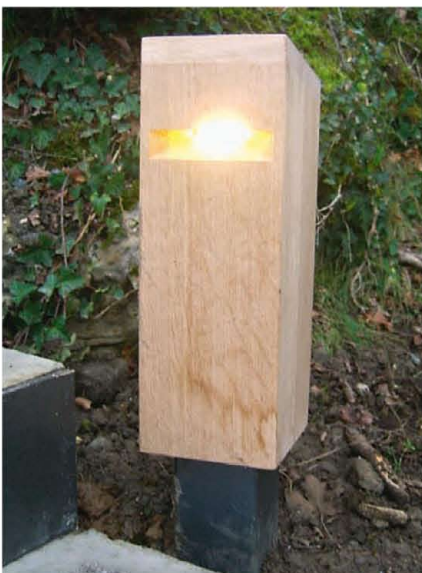
Pollerleuchten aus Eiche auf Stahlfuss beleuchten die Treppenstufen.
