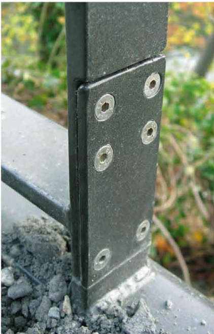
Detail Verbindungselement beim Geländer aus Flachstahl.
